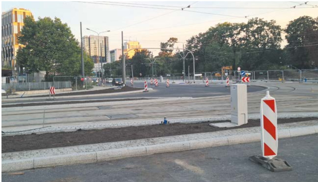
Trwa układanie chodników, znikają ogrodzenia
