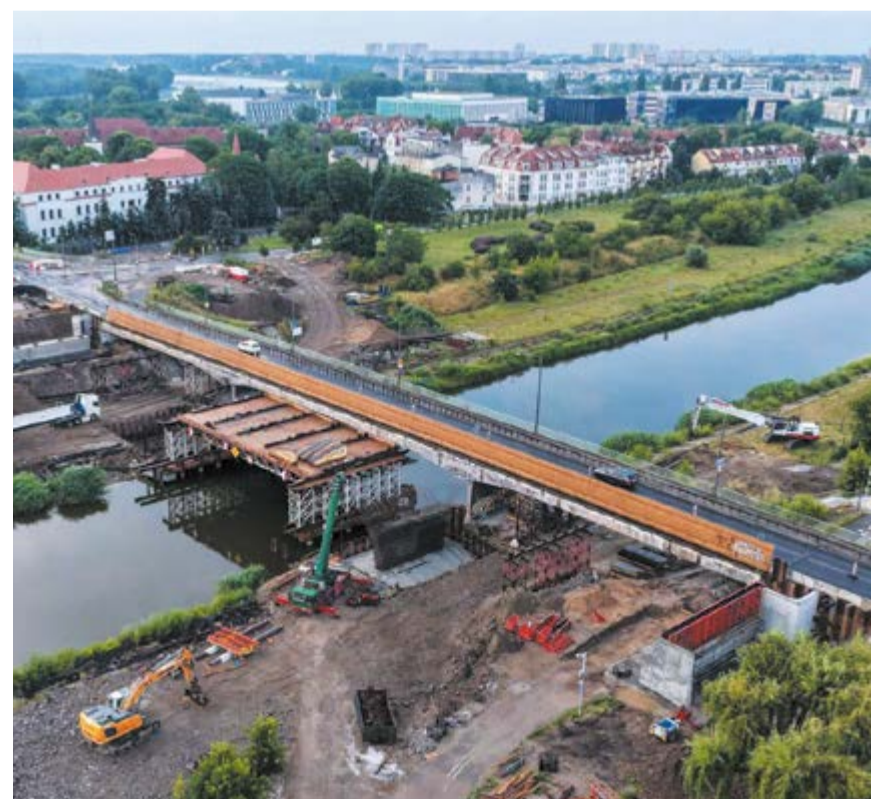
Na plac budowy dotarły pierwsze elementy stalowej konstrukcji
