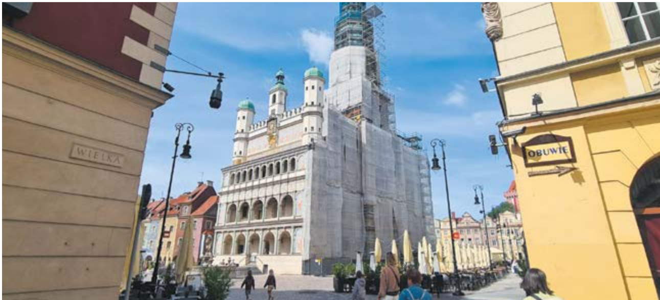
Trwa remont poznańskiego Ratusza. Prace potrwać do końca przyszłego roku
