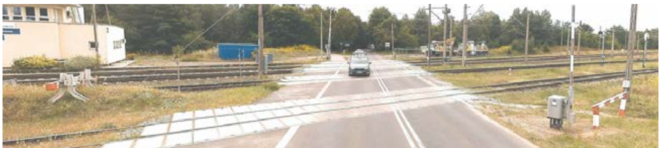
Przejazd będzie zamknięty do 9 marca
