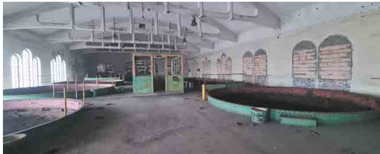
Hala filtrów przy ul. Łaziennej
