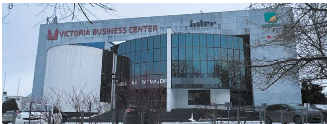
Budynek będzie wyburzony
