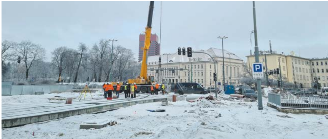
Po nieco ponad dwóch miesiącach prac rozpoczął się tam montaż pierwszego rozjazdu tramwajowego
