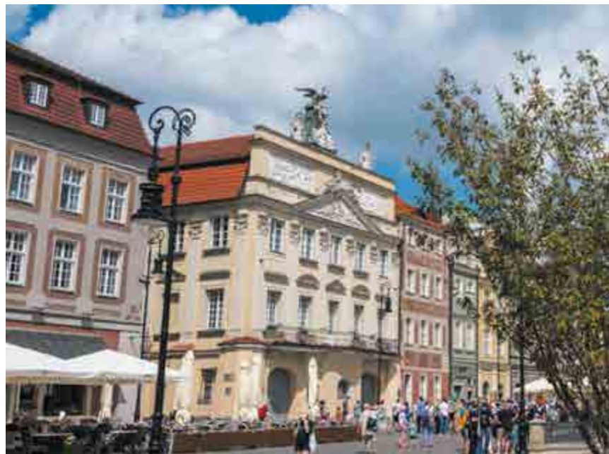
Zakres robót był szeroki – od konserwatorskich, po budowlane
