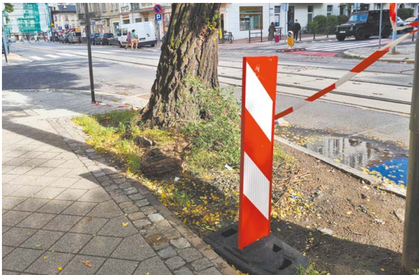
Ulica Kraszewskiego czeka na remont
