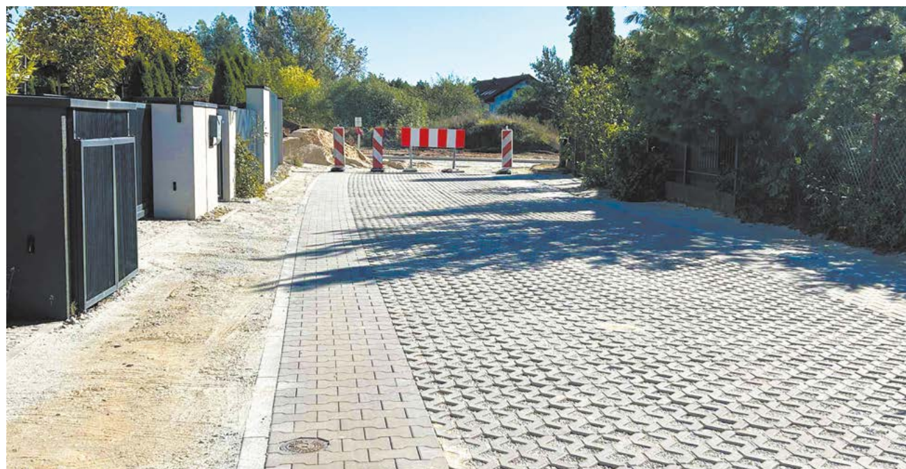
Najwięcej ażurowych dróg jest na Umultowie i Antoninku
