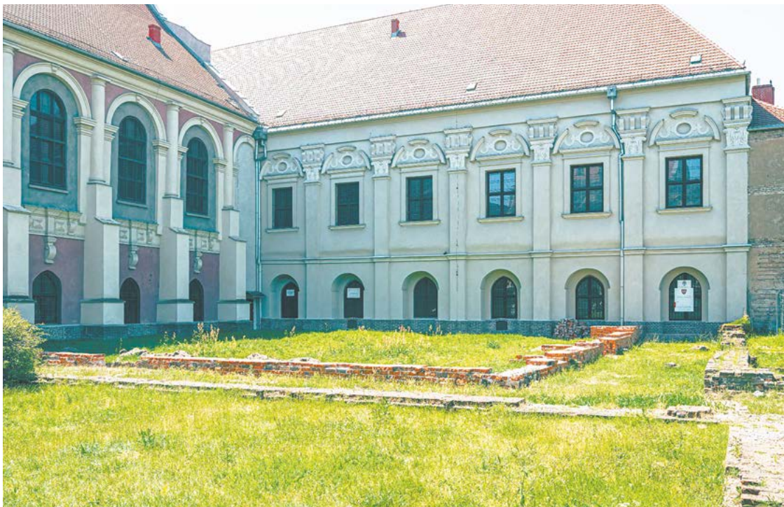
Skwer przy Garbarach wreszcie doczeka się remontu
